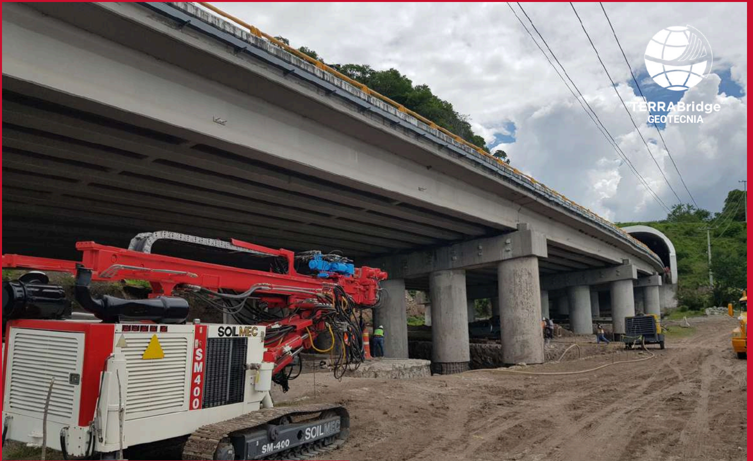
RECIMENTACIÓN DE VIADUCTO CON MICROPILOTES EN LA AUTOPISTA CUERNAVACA-ACAPULCO.
