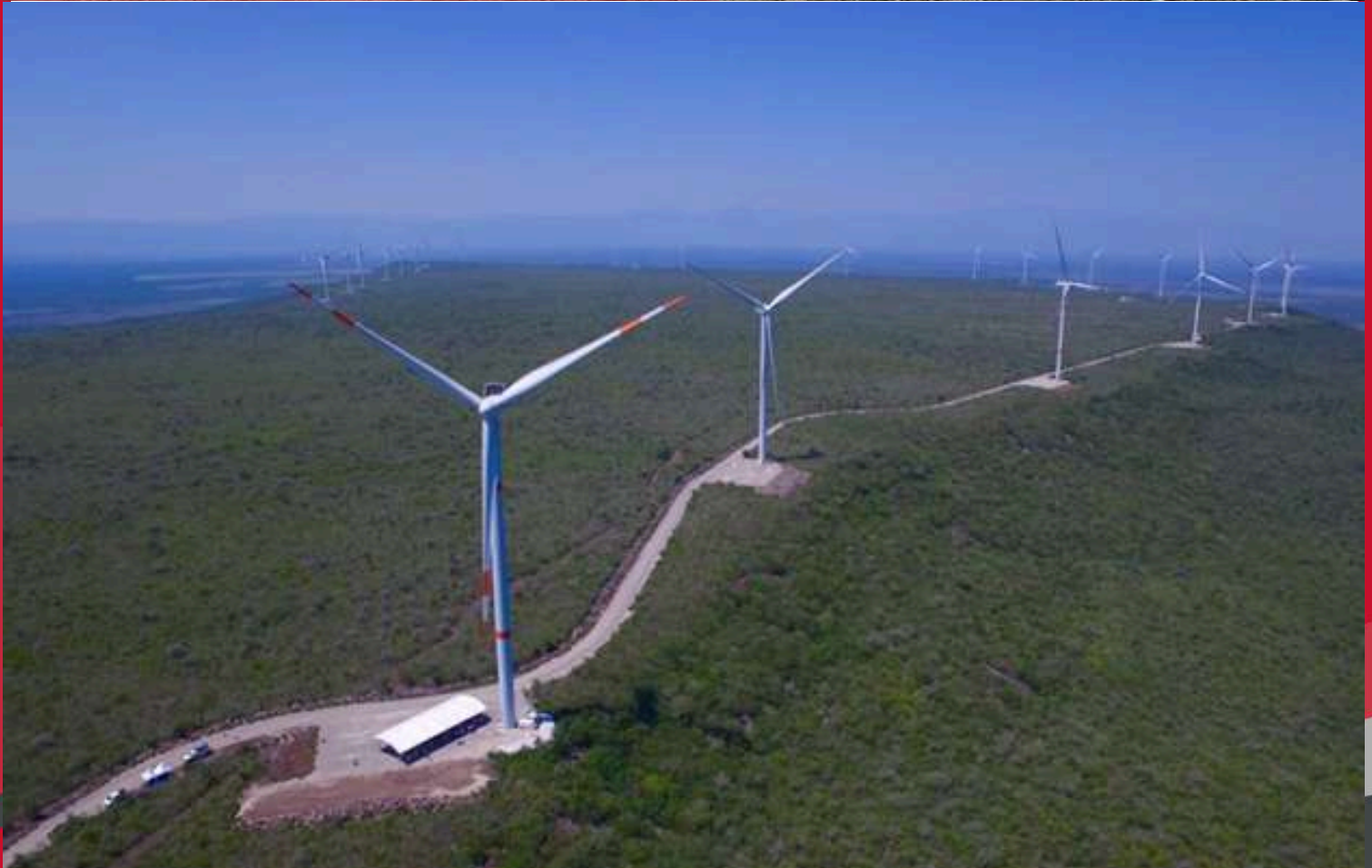
2.- PARQUE EÓLICO REYNOSA, TAMAULIPAS.
