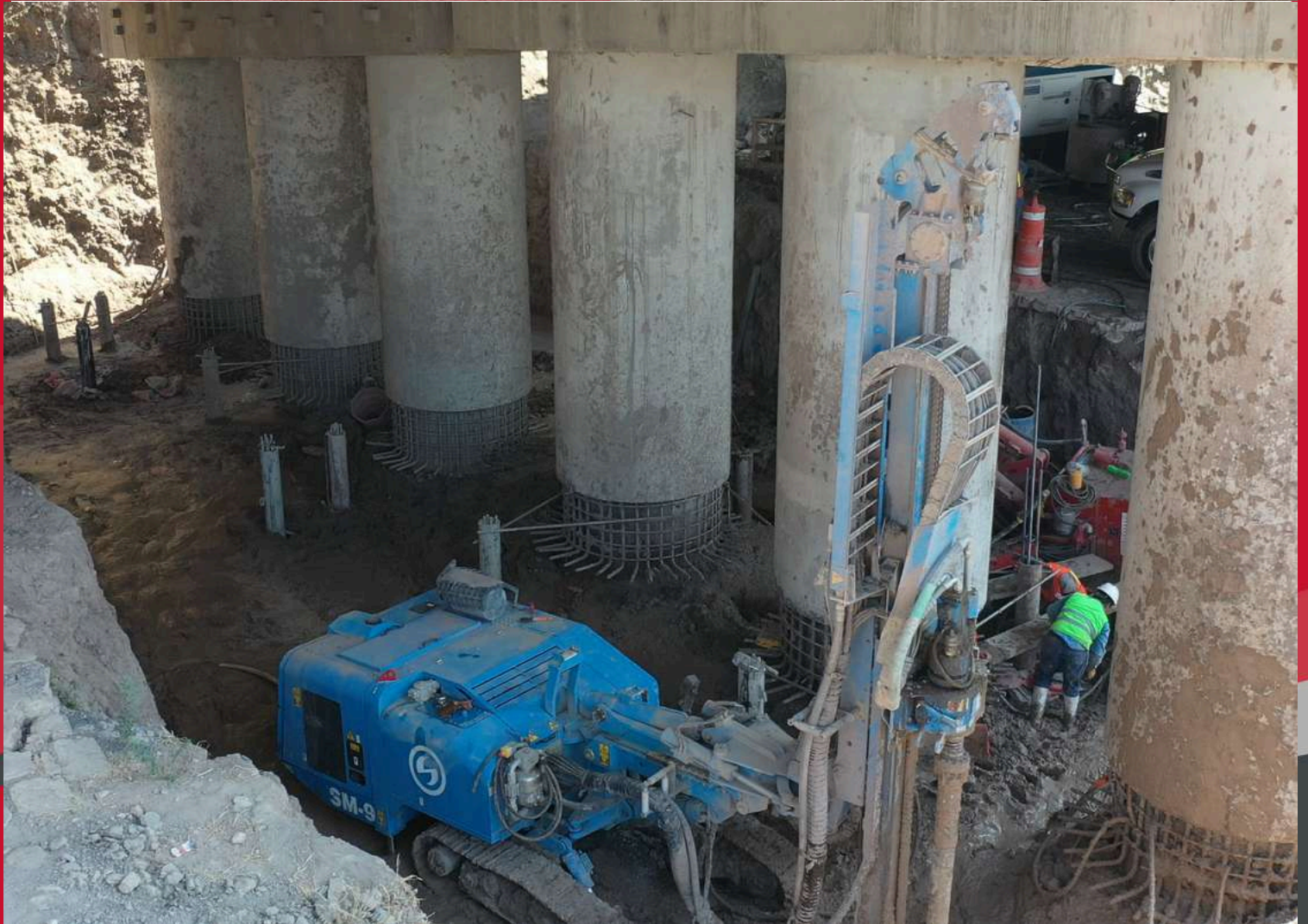
RECIMENTACIÓN DE VIADUCTO CON MICROPILOTES EN LA AUTOPISTA CUERNAVACA-ACAPULCO.
